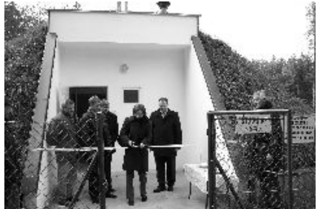
Oddanie do użytkowania ujęcia wody i wodociągu w Sigiółkach.
